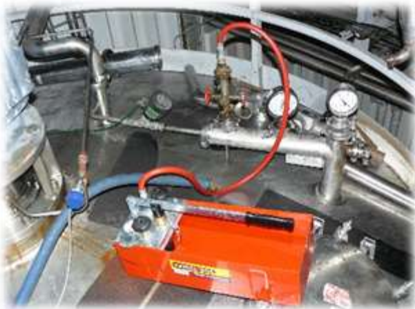
Epreuve hydraulique sur site
